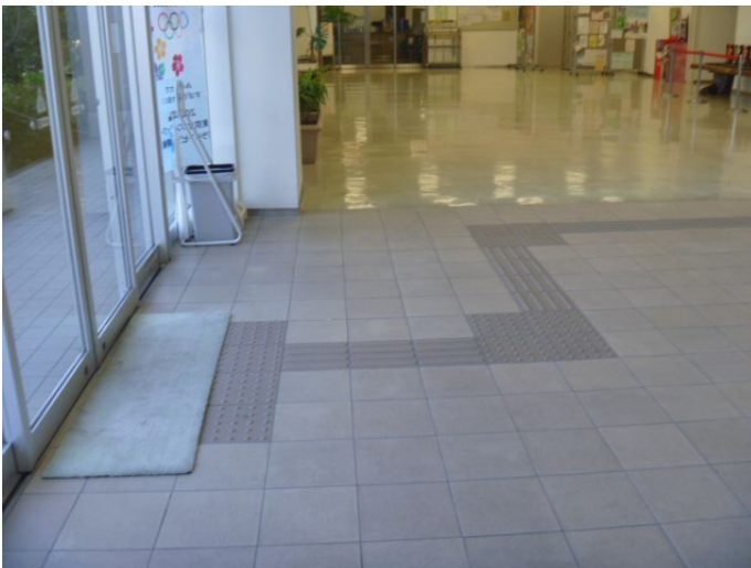
誘導用ブロック 正面玄関
